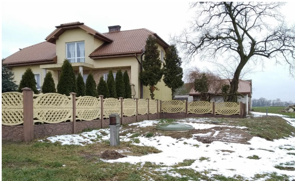
Przydomowa oczyszczalnia w miejscowości Kielbowo
