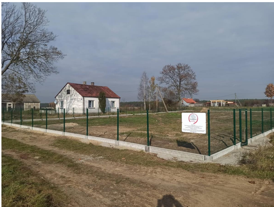
Wykonanie ogrodzenia na potrzeby sportowo-rekreacyjne w Kraszewie Podbornym
