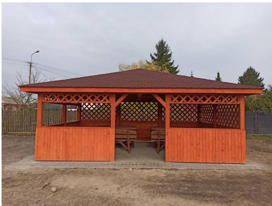
Zakup i montaż altany oraz położenie kostki betonowej w Lipie
